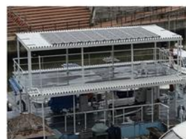
太陽光パネル
